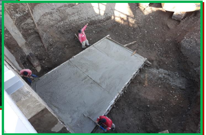
Betonare fundație aripi amonte
