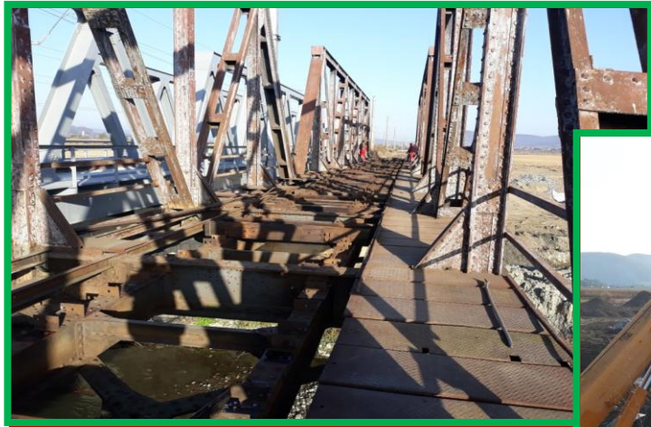
Dezafectare pod vechi
