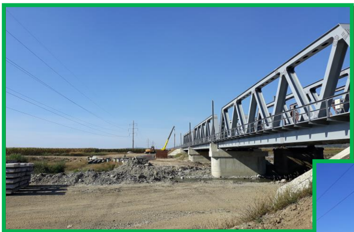
Montare stâlpi LC
