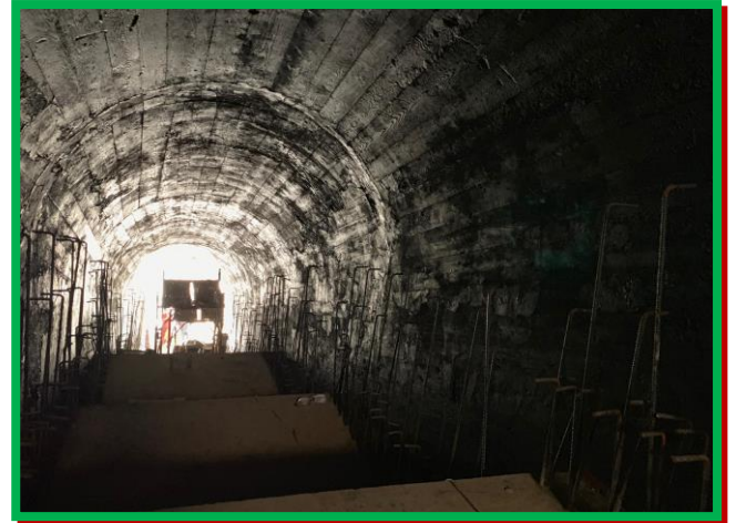
Strat suport hidroizolație structură existentă
