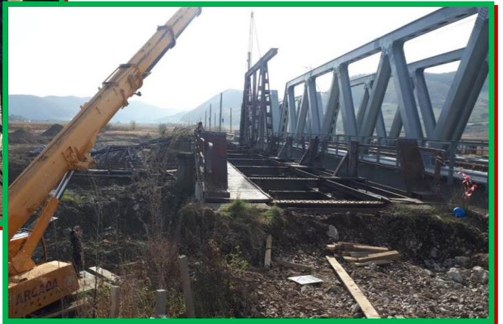
Demontare pod vechi
