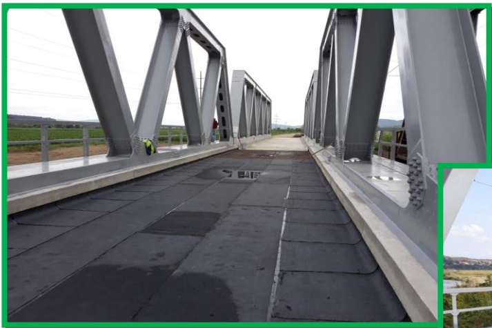
Aplicare hidroizolație tronson II
