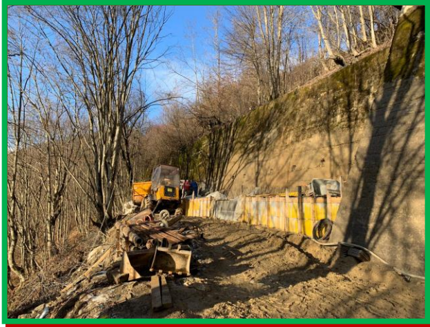
Fundație zid de sprijin aval
