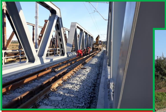
Montare contrașini pe pod
