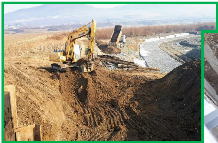
Săpătură amenajare albie și montare saltele gabioane
