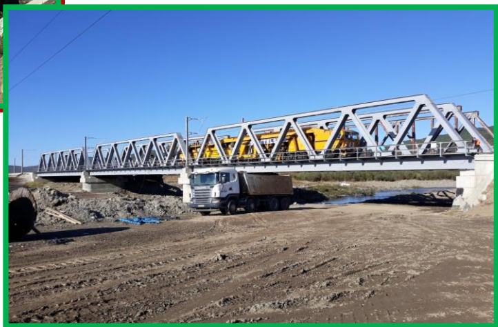
Buraj suprastructură nouă
