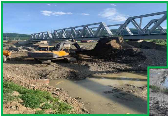
Lucrări in albie
