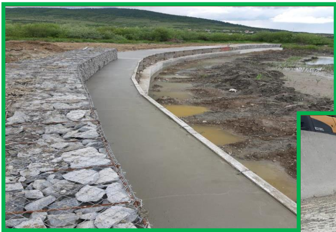
Placare cu beton gabioane
