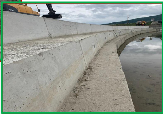
Placare cu beton gabioane
