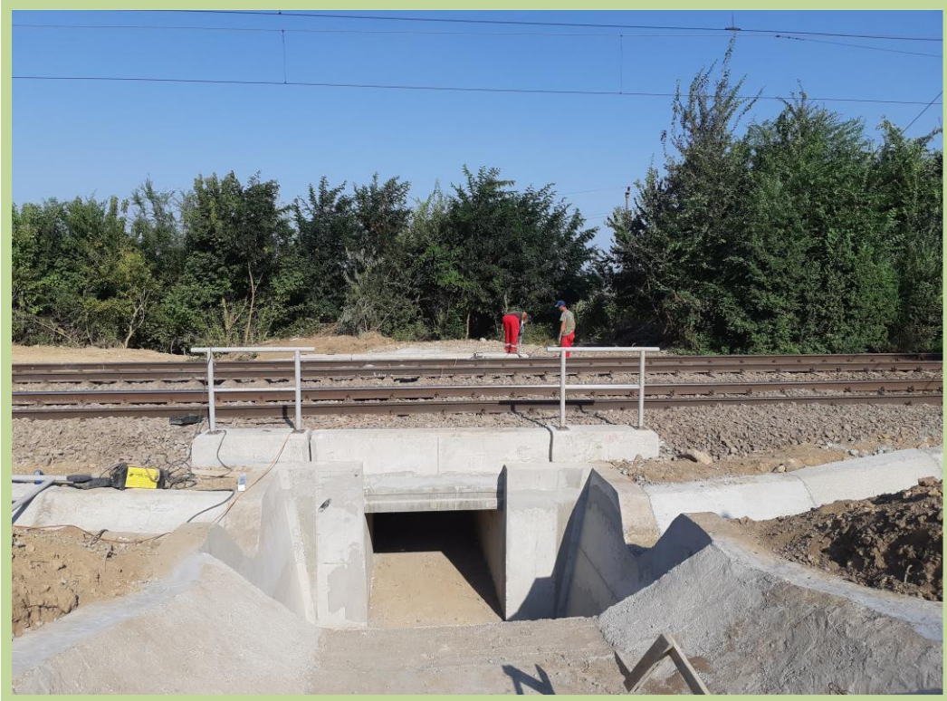
Pod km. 16+660, linia Bacău – Bicz
