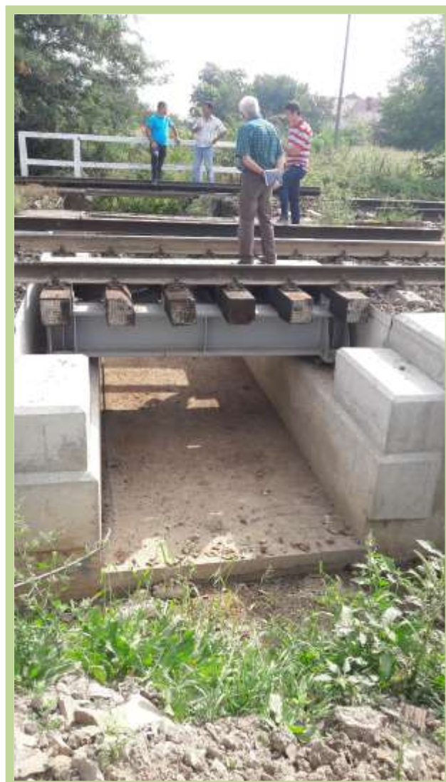
Podet km. 322+537 linia CF Ploiești – Vicșani, Stația Galbeni
