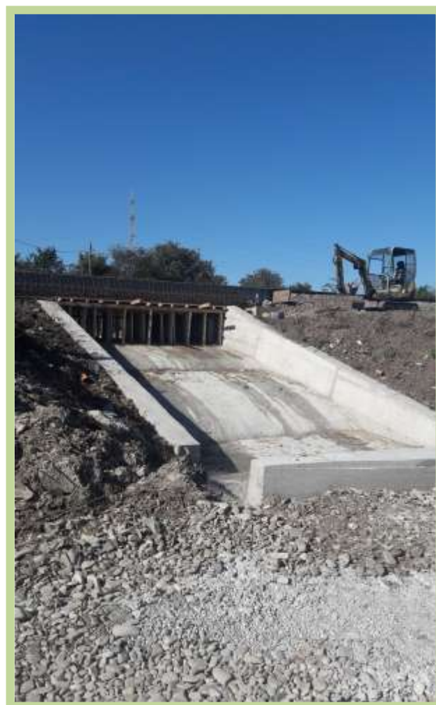
Pod km. 381+660 linia CF Tecuci - Iași
