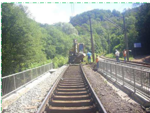
Decolmatare piatră spartă, pod fir I
