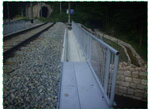
Montare grătare metalice trotuare, pod fir I
