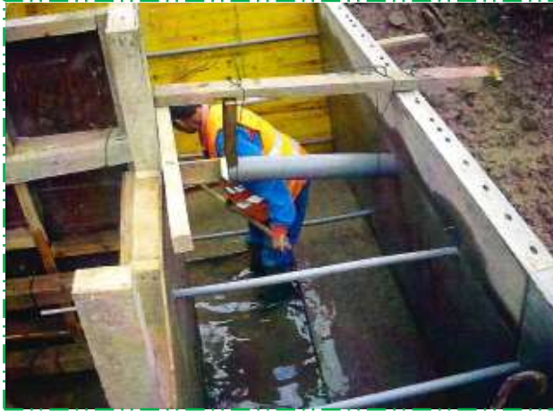
Cofrare, armare, turnare beton în banchetă dren tronson 4
