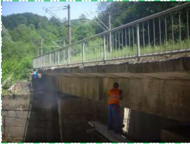
Reparații suprafețe de beton
