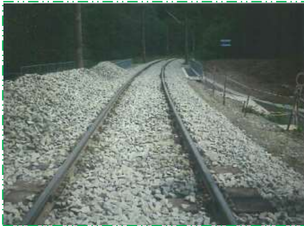
Completare cu piatră spartă linie CF
