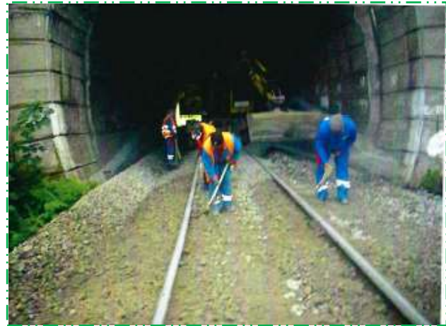
Scarificare piatră spartă, în vederea deschiderii circulației
