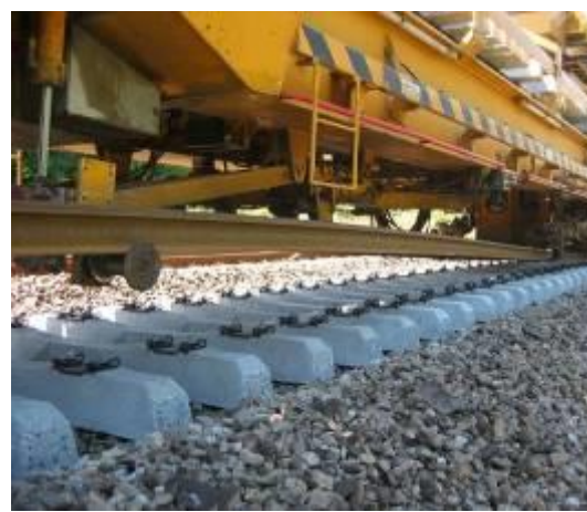
d) montarea șinelor noi
