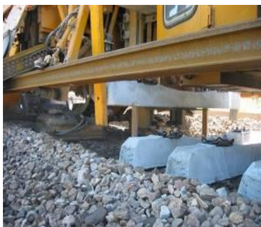
c) montarea traverselor noi
