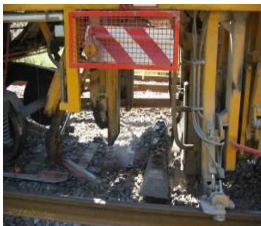
a) înlăturarea traverselor vechi
