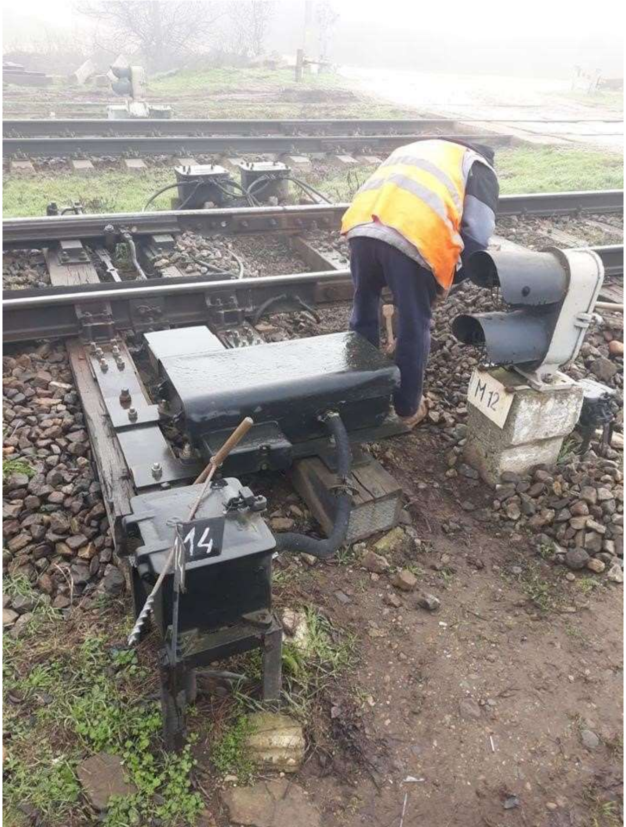
Lucrari de mentenanta in regie proprie Statia Padureni L4 Focsani
