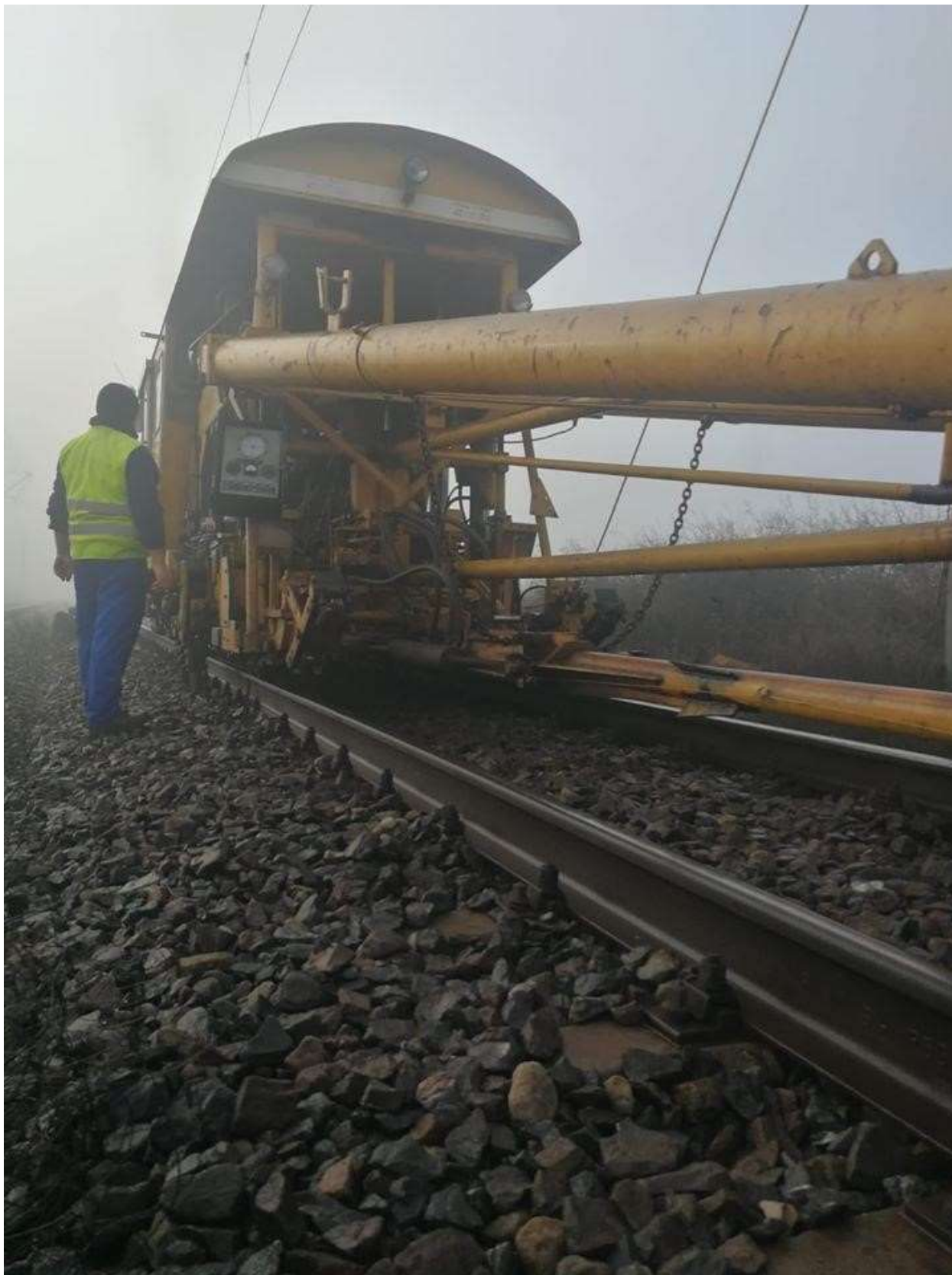
Lucrări de mentenanță în regie proprie Eremia Grigorescu Cosmești L4 Focsani
