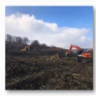
202102-Viaduct km 254+400 - Săpătură fără sprijiniri culee 1 și pila 1
