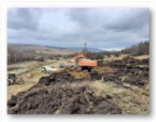
202102-Paloz 1 km – 242+700 Profilare taluz Fir II_2
