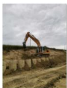
202106_Săpătură în ampriză, săpătură între piloți consolidare
