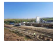
202107_Cofrare și armare grinda de coronament - consolidare Beia km 247+295 + 247+633
