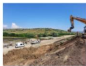
202107_Betonare și taluzare consolidare cu piloți Beia km 247+295 + 247+633
