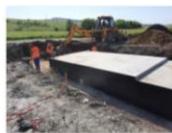
202106_Umpluturi compactate în stratul în jurul fundației podețului km 239+365
