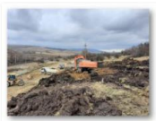
202102-Paloz 1 km – 242+700 Profilare taluz Fir II_2
