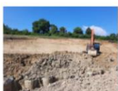
202106_Săpătură în ampriză, săpătură între piloți consolidare și taluzare km 242+448 + 242+929
