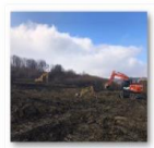
202102-Viaduct km 254+400 – Săpătură fără sprijiniri culee 1 și pila 1
