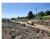
202106_Săpătură între coloane forate consolidare km 242+448 + 242+929
