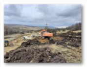
202102-Paloș 1 km – 242+700 Profilare taluz Fir II 2
