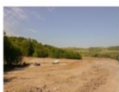
Livrare beton in santier
