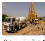
Betonare pilot-1
