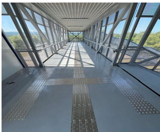
Stația Câmpuri Surduc – execuție marcaj tactil
