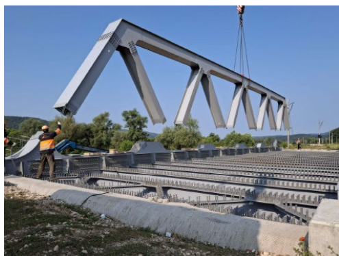
Câmpuri Surduc – montare tăblîer pod km 529+546
