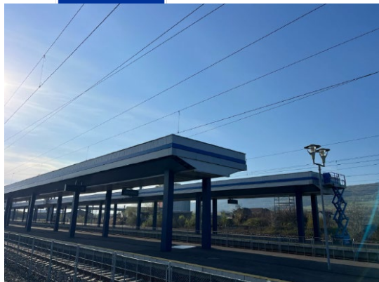
Stația Mintia - structură secundară copertină peron 3
