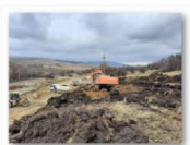
202102-Paloș 1 km – 242+700 Profilare taluz Fir II_2
