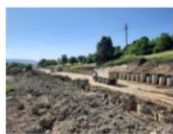
202106_Săpătură între coloane forate consolidare km 242+448 ÷ 242+929
