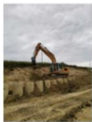
202106_Săpătură în ampriză, săpătură între piloți consolidare
