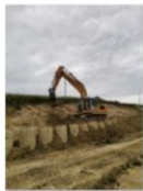
202106_Săpătură în ampriză, săpătură între piloți consolidare
