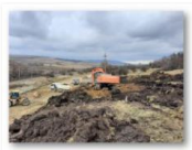
202102-Paloș 1 km – 242+700 Profilare taluz Fir II_2
