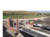
202107_Cofrare fundații aripi prefabricate podet km 248+495
