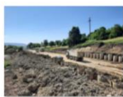
202106_Săpătură între coloane forate consolidare km 242+448 ÷ 242+929
