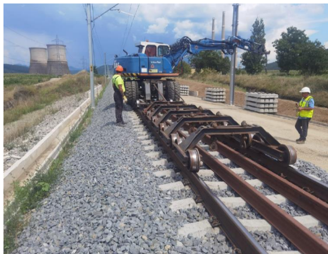
Zona Micia: lucrări de terasamente și suprastructură
