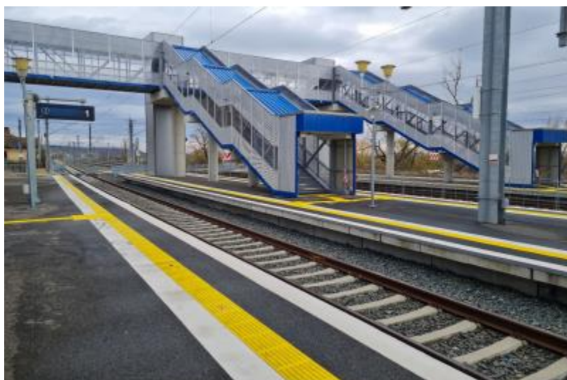
Stația CF Păuliș: lucrări de marcaj pod
