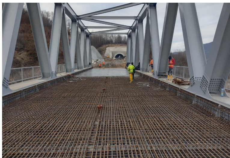
Interval Câmpuri Surduc - Ilteu - Km 524+704: betonare dală
