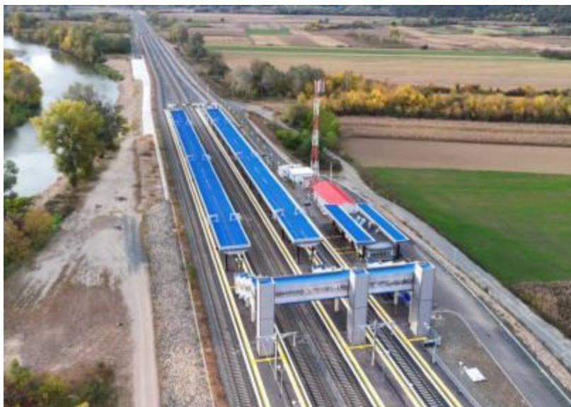
Stația Milova km 582+800 - km 585+125
