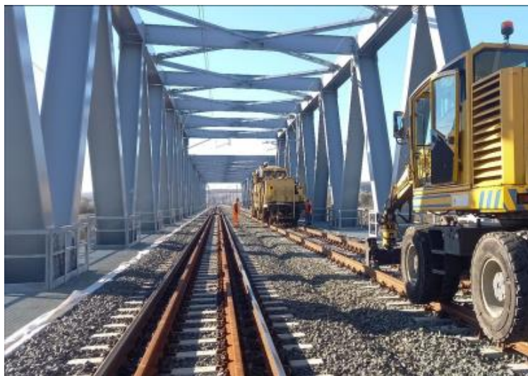
Interval Vărădia - Bârzava: lucrări de buraj Fir I pod km 554+868
