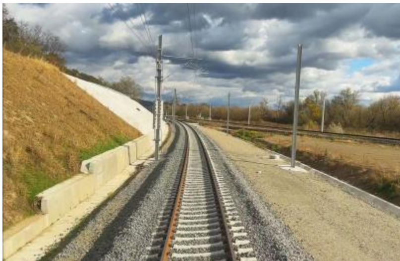
Vărădia - Săvârșin: lucrări de deschidere linie fir I
