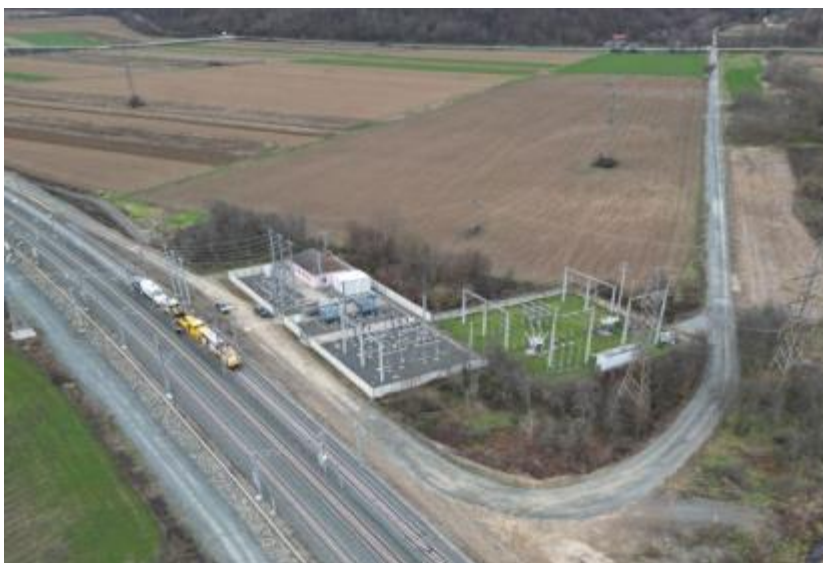
Interval Vărădia - Bârzava: lucrări realizarea drum de acces la stația Vărădia km 550+860
