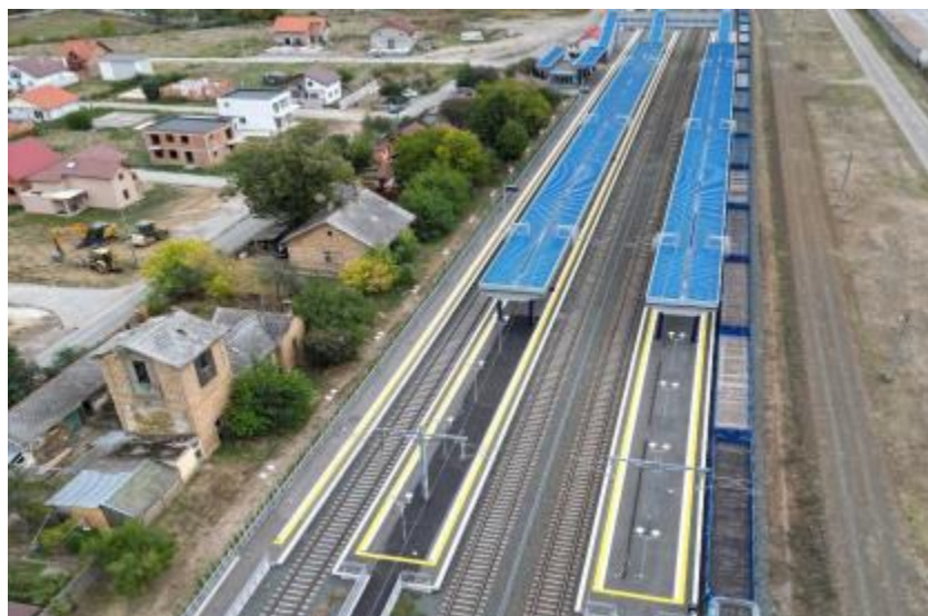
Stația CF Ghiroca: lucrări de remediere alee pietonală și împrejmuire
