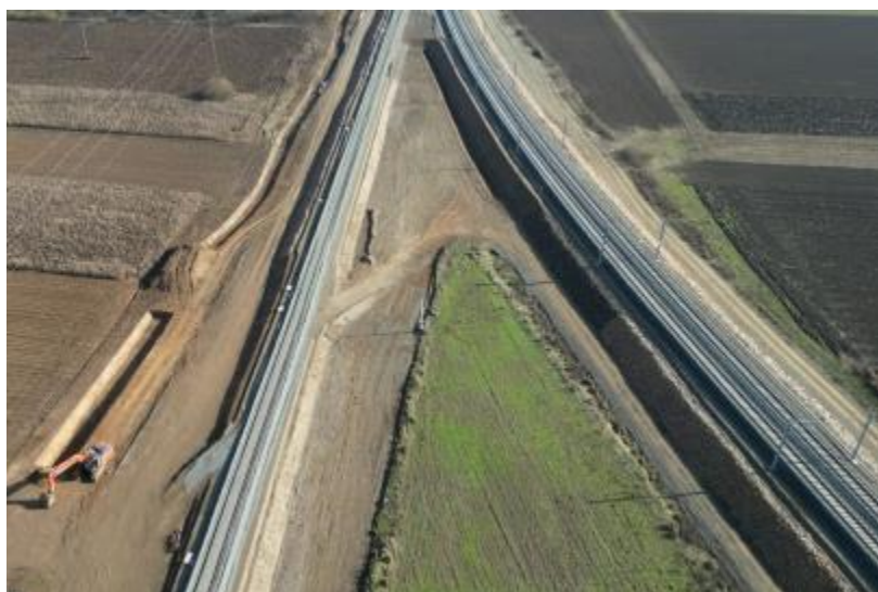
Interval Vărădia - Bârzava: lucrări de așternere piatră spartă cale ferată și execuție șanț km 552+700 - km 553+400 spre linia veche stația Bătuța
