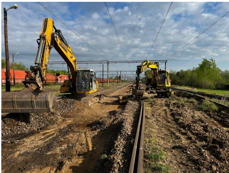
Stația Caransebeș Triaj - lucrări suprastructură
