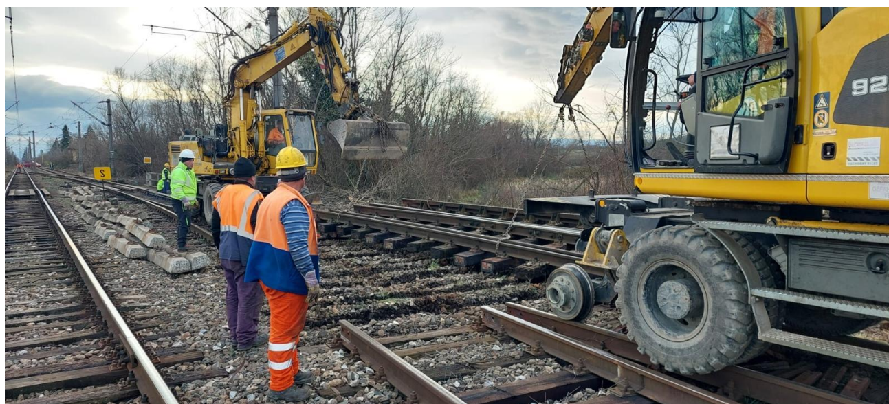
Interval Zăgujeni - Căvăran - lucrări suprastructură, demonțare sch 4 și înlocuire cu panou
