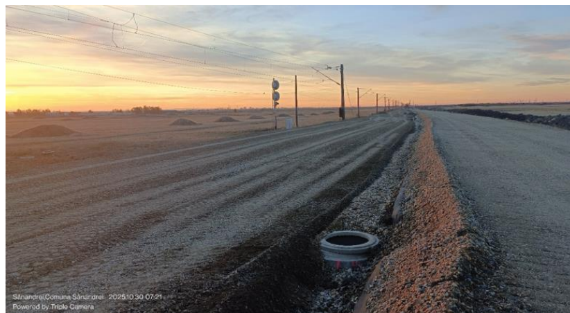
Stația Sânnandrei - substratul căii liniile III+4 km 12+300 - 12+540
