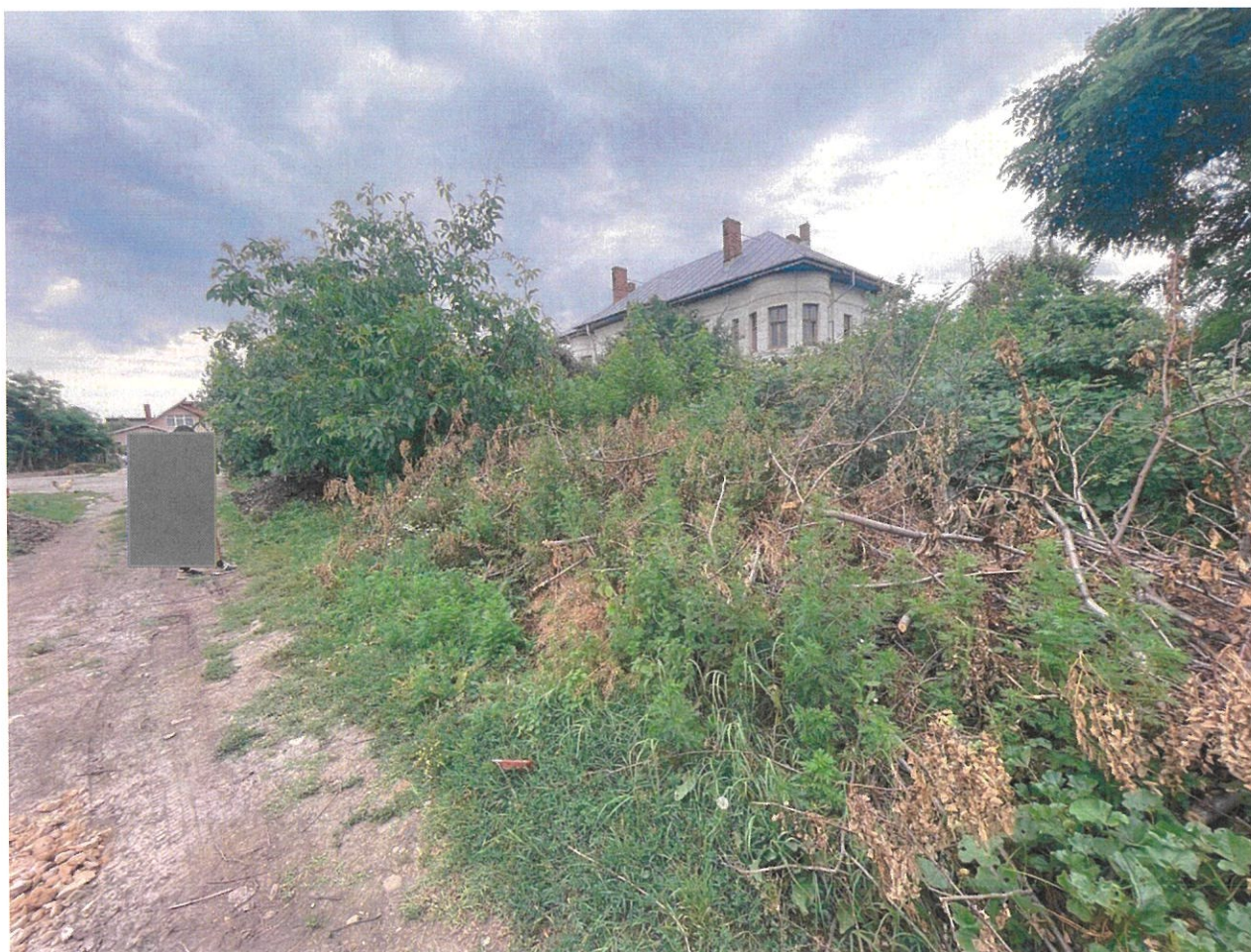
Stația CF Săhăteni – depozitare și comercializare materie lemnoasă – 100mp
