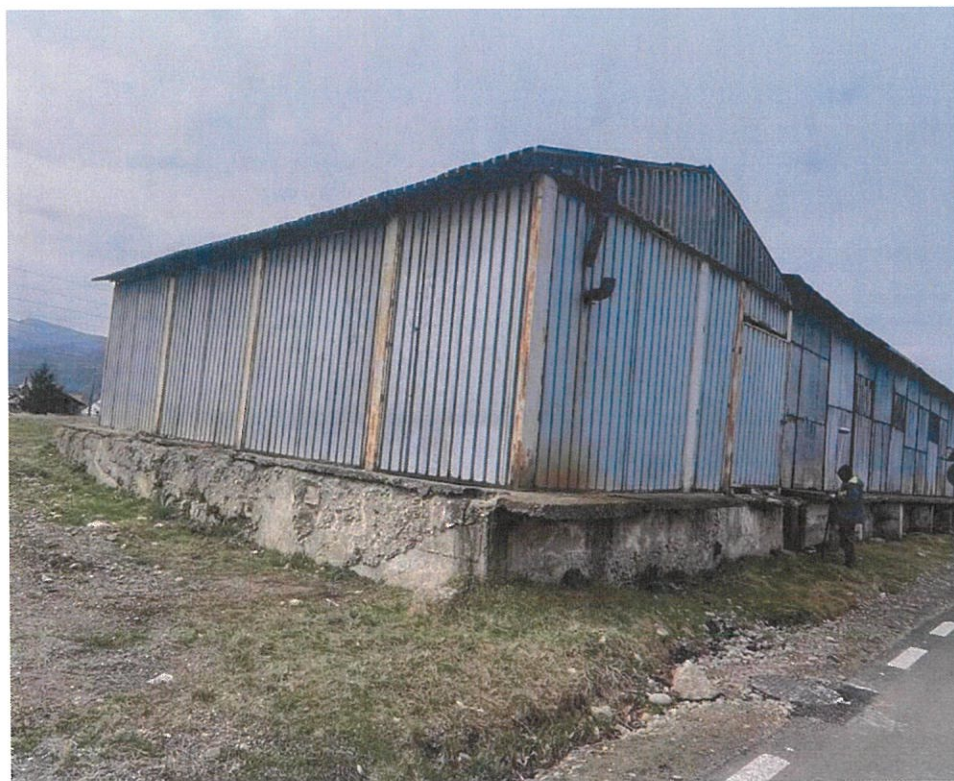
Stația CF Târgu Ocna – teren aferent construcție – 126mp
